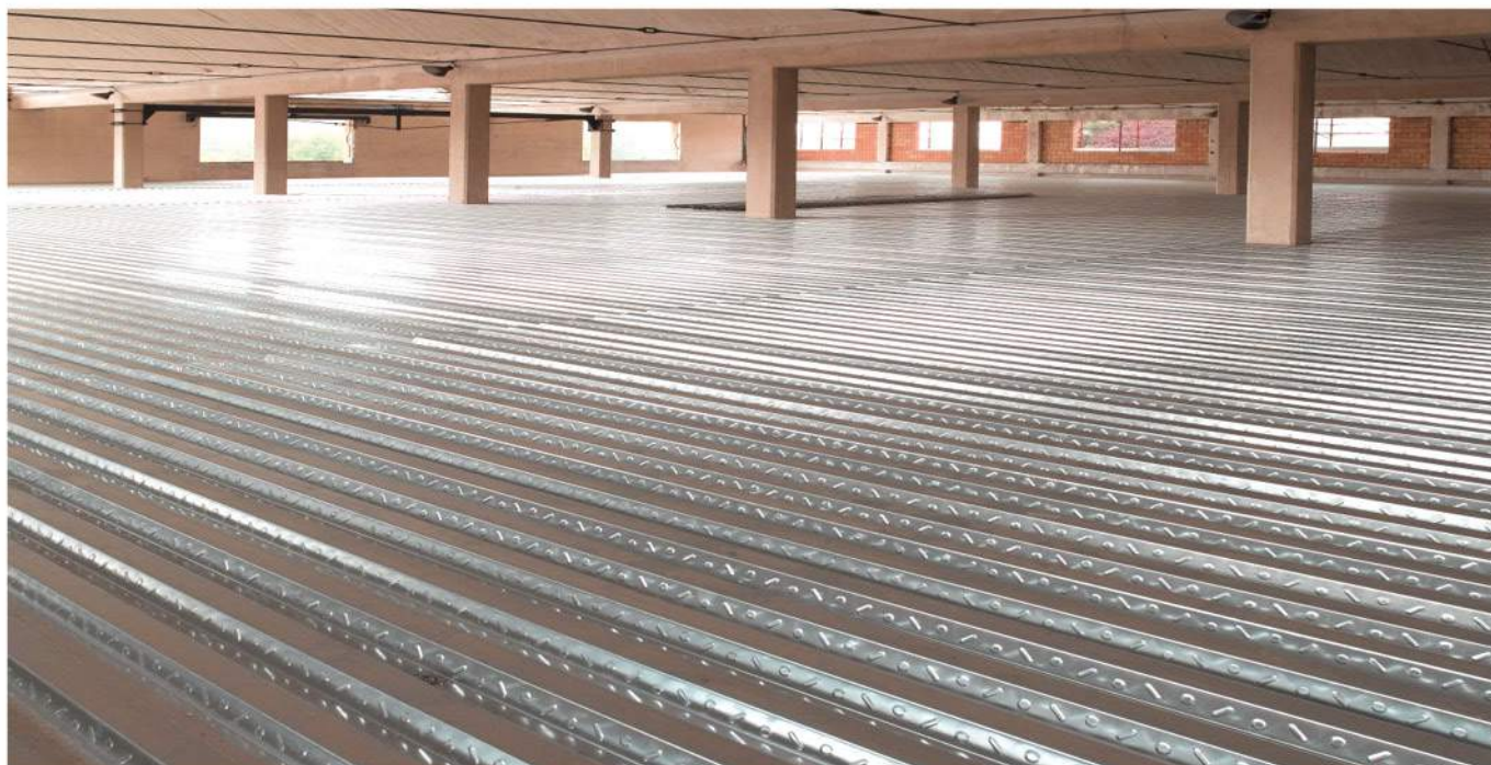
Sotto tetto con solaio collaborante.
